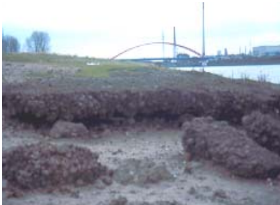
Schlackebefestigung vorher Basaltblockschüttung vorher
