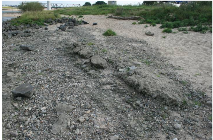
Schlacke unter der früheren Basaltblockschüttung
