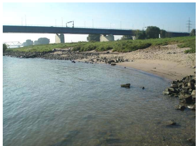
Basaltblockschüttung auf Probestrecke entfernt
