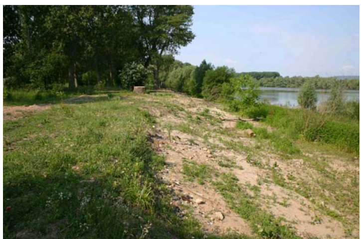
Uferabschnitt nach Rückbau der Mauer (2005)
